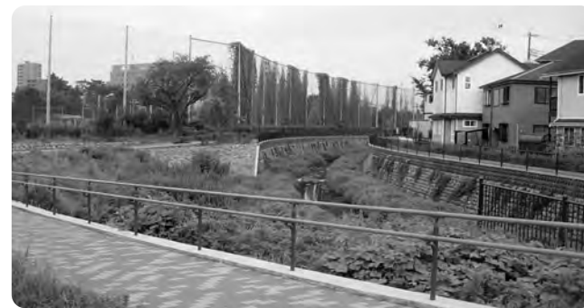
早稲田大学東伏見総合グラウンド付近(緩傾斜自然再生工法)
